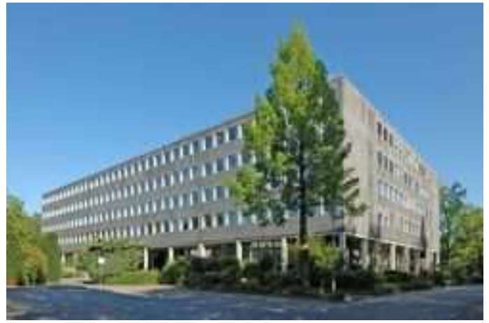
Frontansicht des Gerichtsgebäudes
